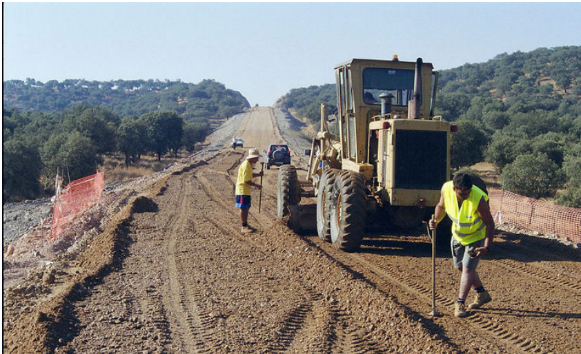
Imagen 2. Trabajos de mejora y ampliación de carreteras. Fuente: Diputación de Badajoz
