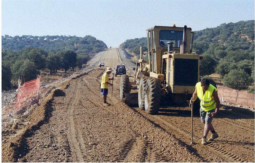
Imagen 8. Ensanche y arreglo del firme de carretera. Fuente: Diputación de Badajoz
