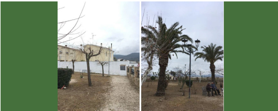
Imagen 22. Estado actual de luminarias
